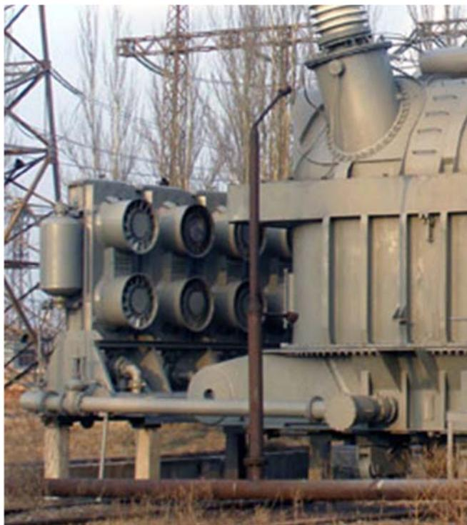
Рис. 3.7. Система охлаждения Ц
