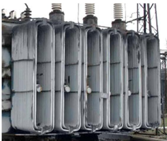
Рис. 3.5. Трансформатор с системой охлаждения Д
