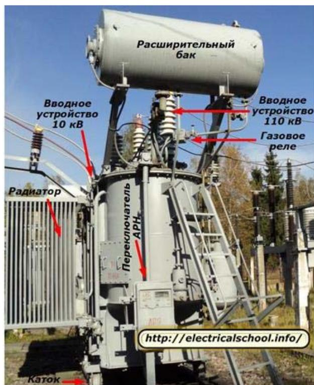
Рис. 3.1. Общий вид силового трансформатора
