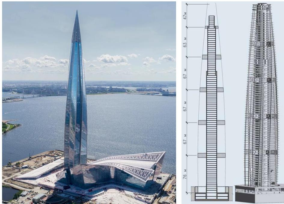
Рисунок 5. Внешний вид и конструкции Лахта центра
