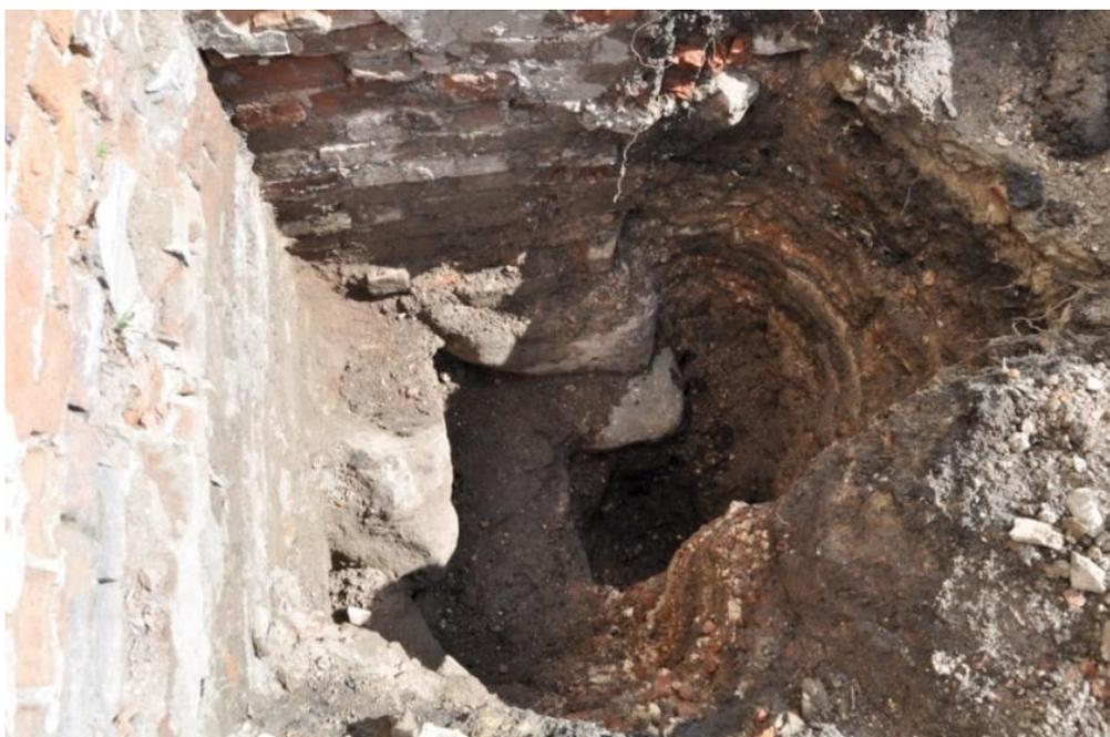
Рисунок 5. Шурф у южной стены Михайло-Архангельского собора в месте сопряжения основного объема и паперти
