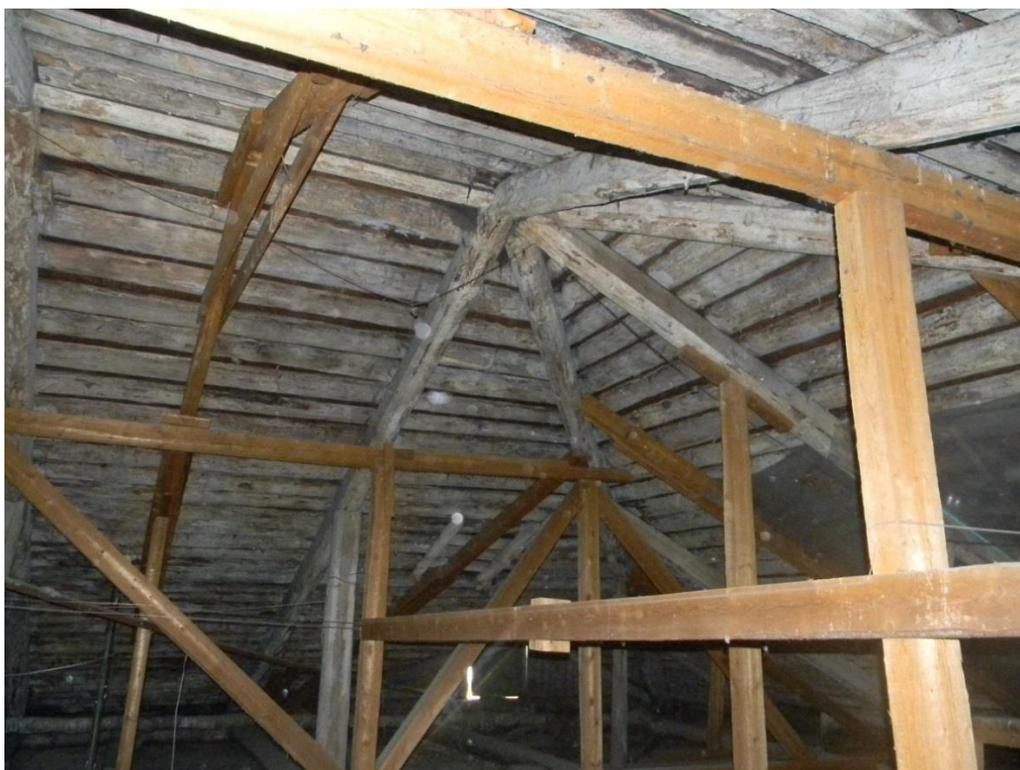
Рисунок 3. Монтаж дополнительных стропильных ног
