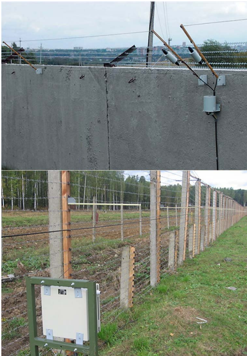
Рис. 2.4. Варианты установки проводноволнового извещателя
