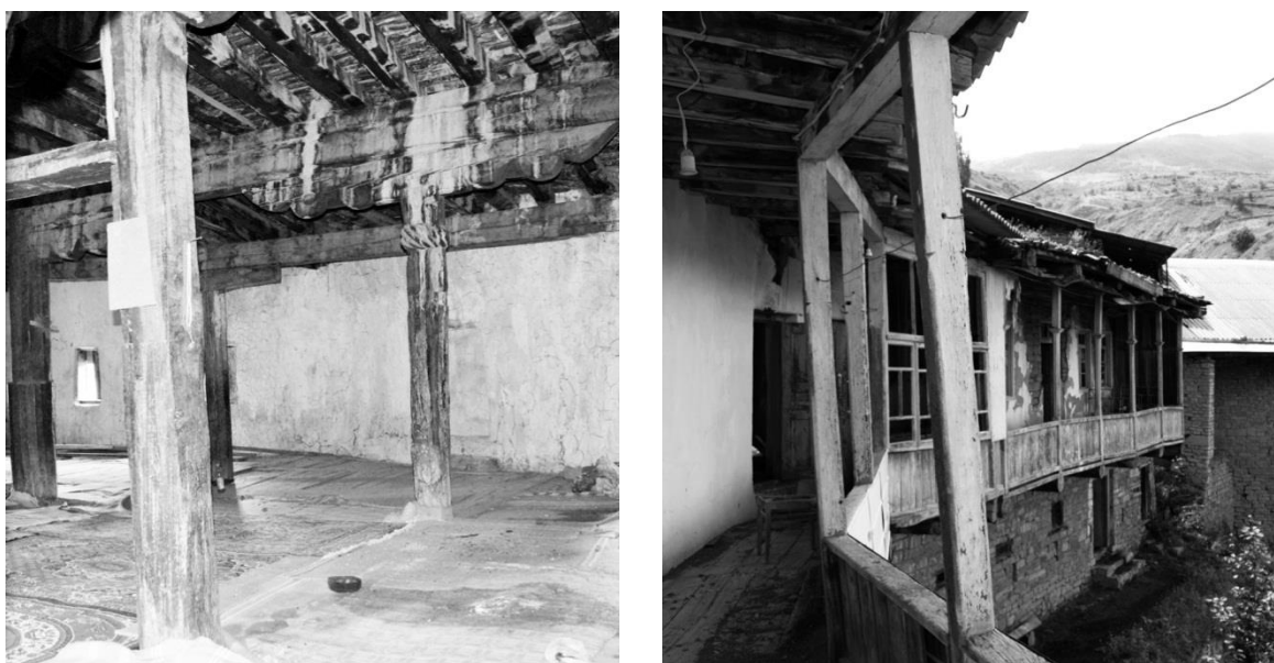
Рис. 1. Деревянная стоечно-балочная система. Интерьер мечети, балкон жилого дома
