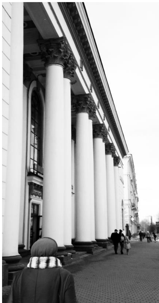
Рис. 4. Композитный ордер
