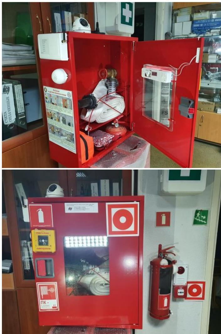
**Рис. 1. Общий вид макета пожарного шкафчика (ШПК)**
