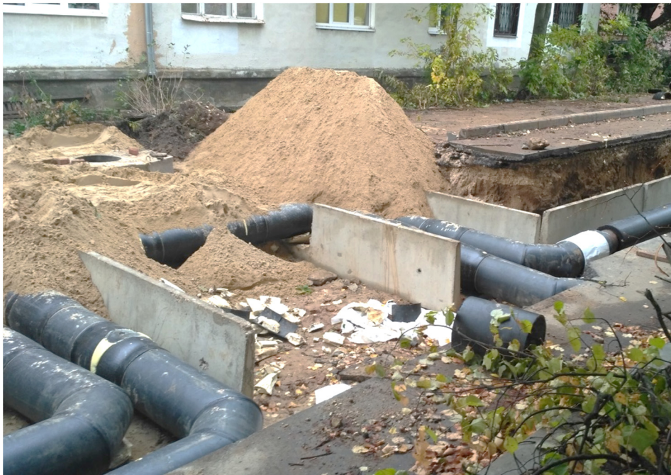
Рис. 12.3. Монтаж П-образного компенсатора
