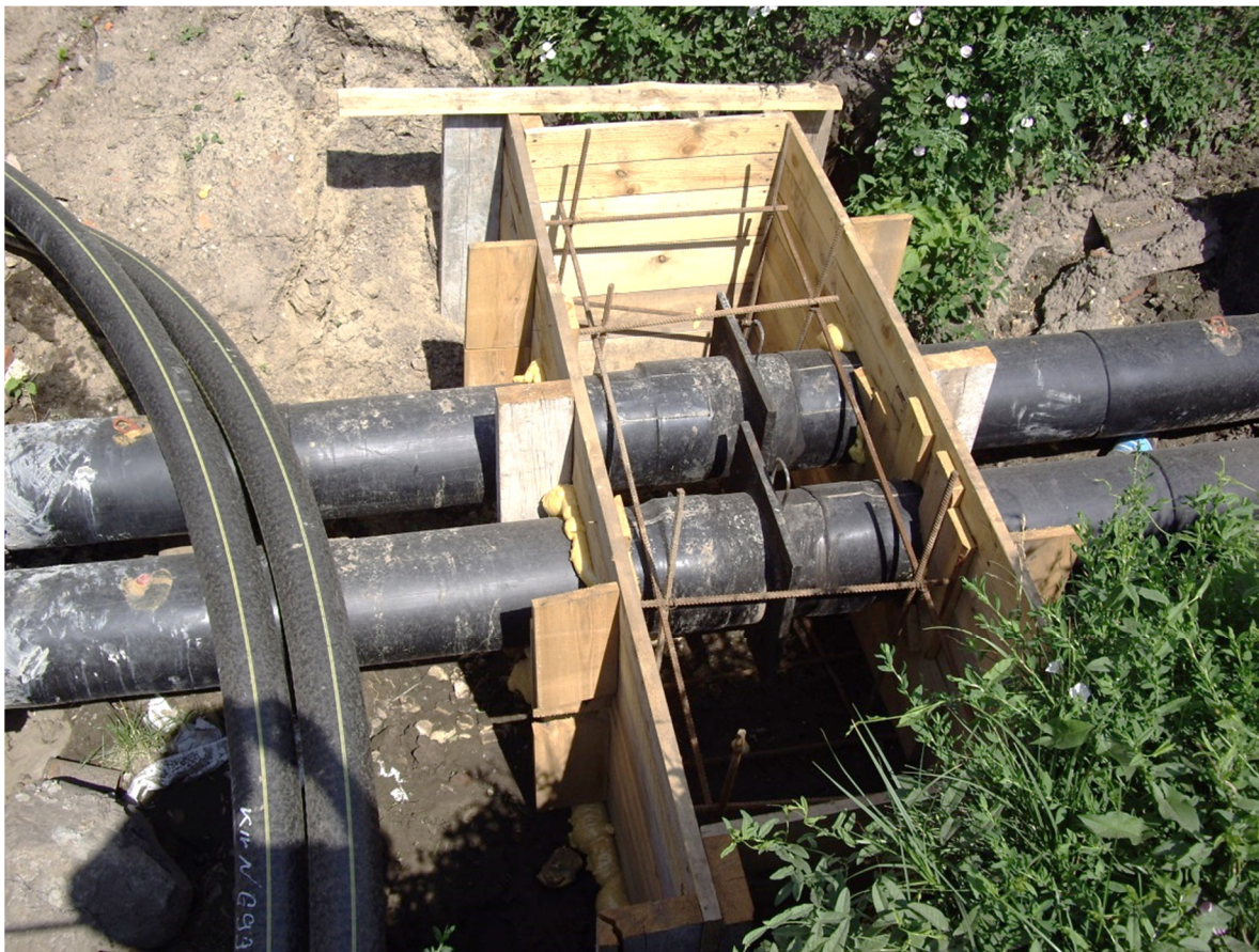
Рис. 13.2. Монтаж неподвижной опоры
