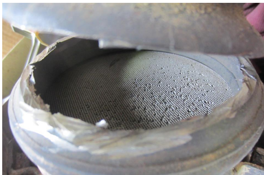
Рис. 4. Состояние представленного каталитического нейтрализатора
