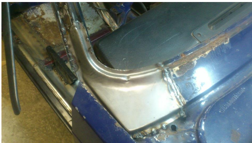
Рис. 1. Пример установки ремонтной вставки на стойку «А» правую автомобиля ВАЗ-2107
