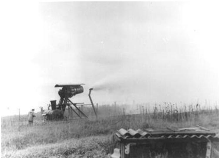
Рис. 47. Предварительные пуски ТРД (20.10.81.). Отладка скоростного напора пароводяной струи по расходу воды и выходным параметрам ТРД. Отладкой руководит проф. Кунин В.Н. (слева)
