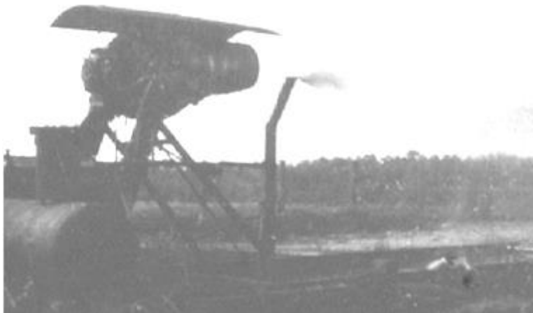
Рис. 2. Компьютерная версия фотографии распылительного узла ввода воды в струю ТРД
