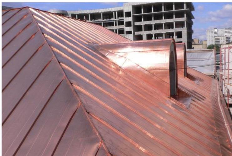
Рисунок 3. Фальцевая кровля из меди и алюминия
