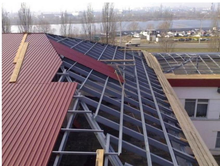
Рисунок 1. Профилированный настил
