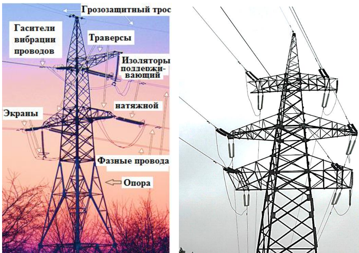
Рис. 1. Фрагменты ВЛ 220 кВ: а – одноцепной; б – двухцепной
