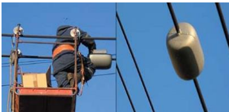
Рис. 42. Монтаж измерительного блока на проводах ЛЭП
