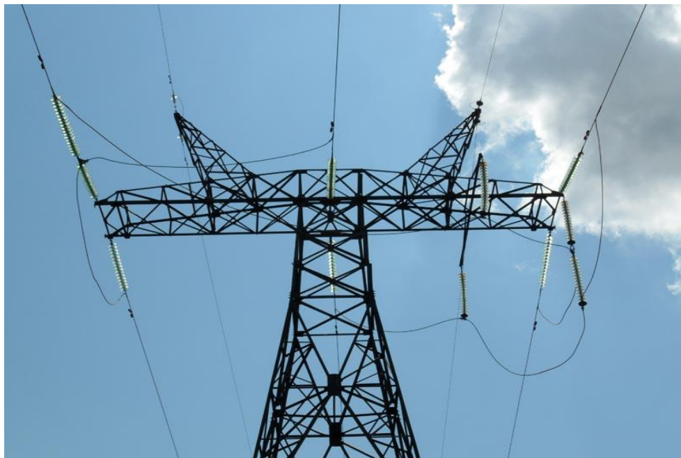
Рис. 4. Транспозиционная опора
