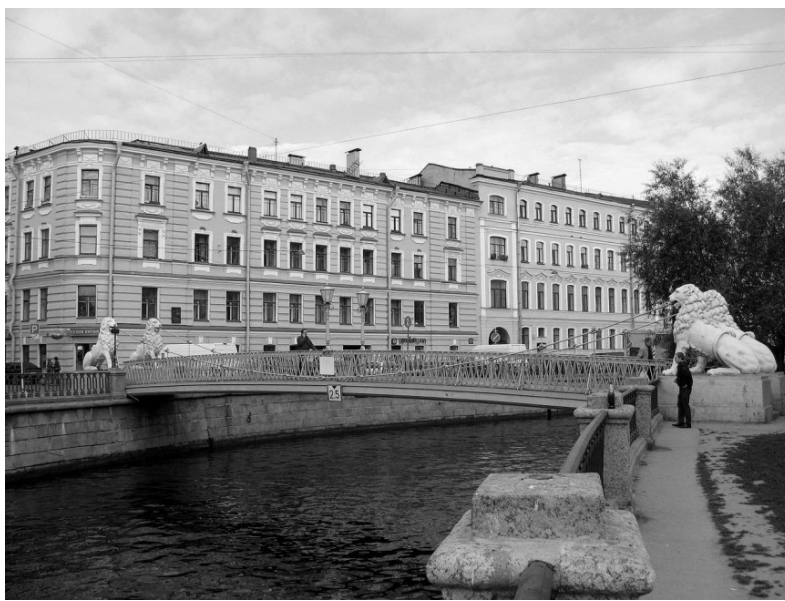
Рис. 3. Львиный мост в г. Санкт-Петербурге [2]
