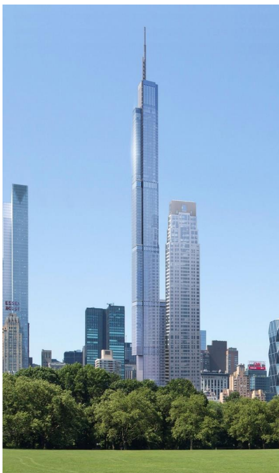
Рис. 2. Central Park tower (Башня центрального парка)
