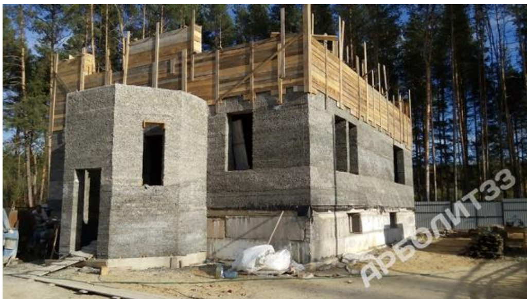
Рис 2. Строительство из деревобетона. Заливка арболитовой смеси [4]
