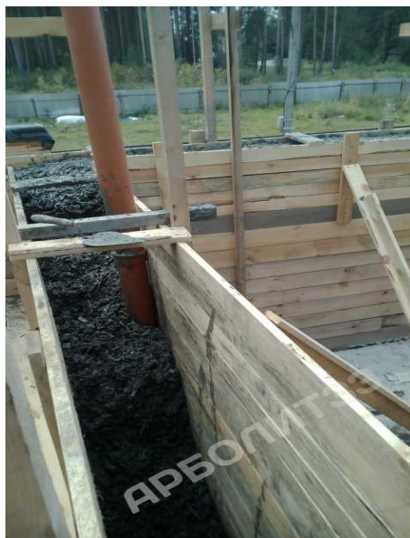
Рис 2. Строительство из деревобетона. Заливка арболитовой смеси [4]
