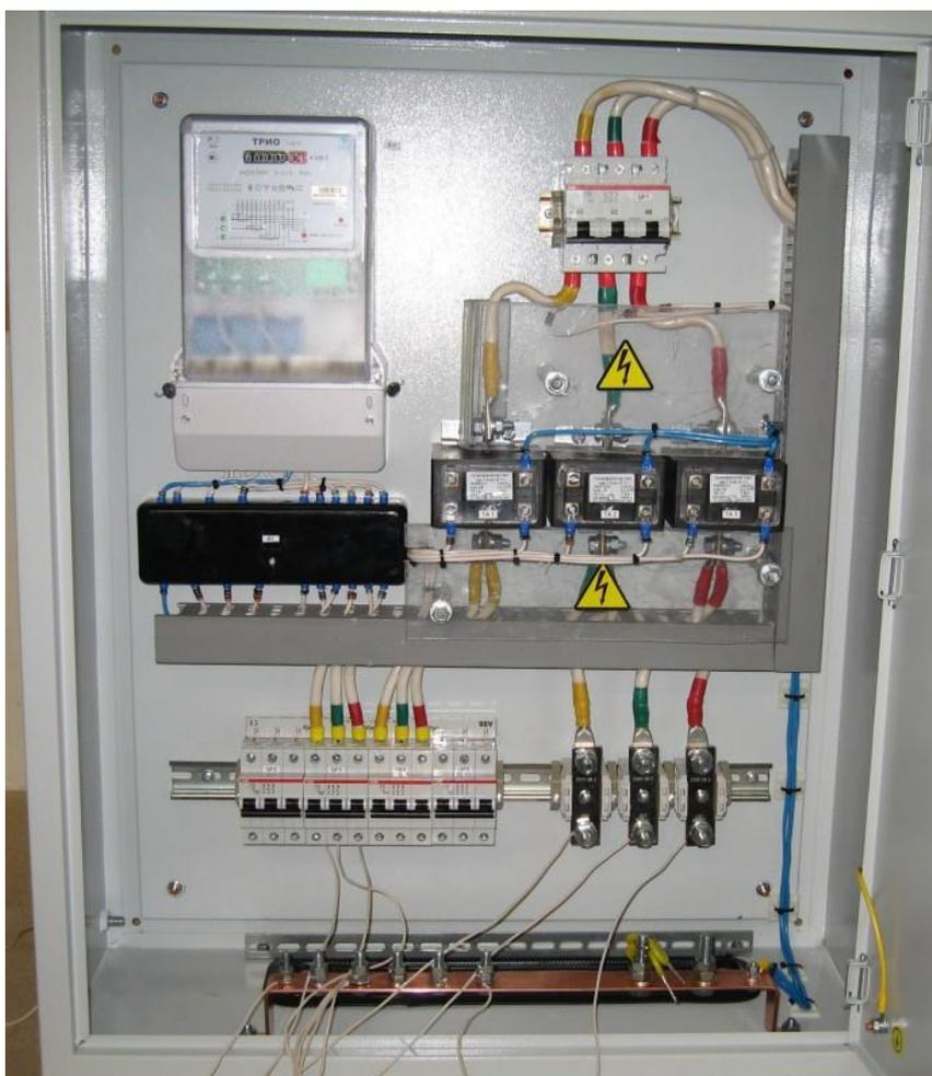
Рис. 10.1. Распределительный щит серии ПР8513
