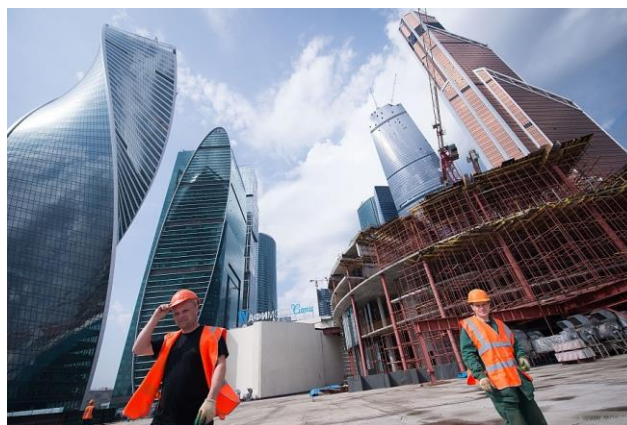
Рис. 1. Строительство международного делового центра «Москва сити»
