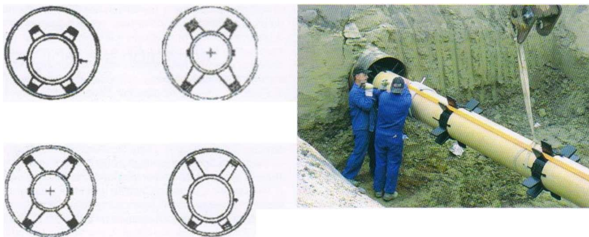
Рис. 1. Позиционирование труб в футляре
