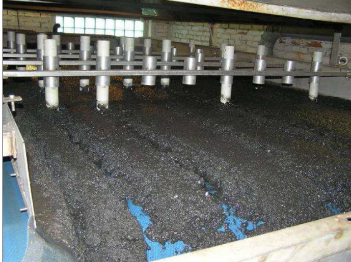
Рис. 2. Сетчатый гравитационный сгуститель ленточного типа ОС г. Владимир
