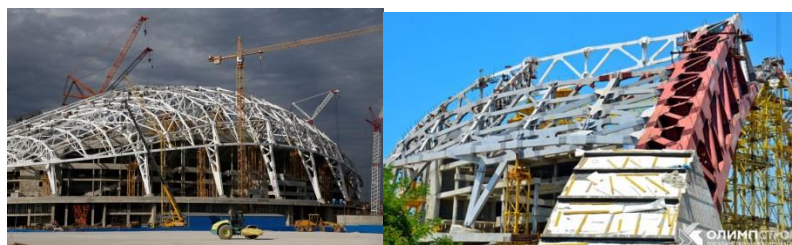
Рис. 7 Стадион «Фишт» стальные конструкции
