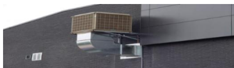
Рис.1. Испарительный охладитель промышленного типа
