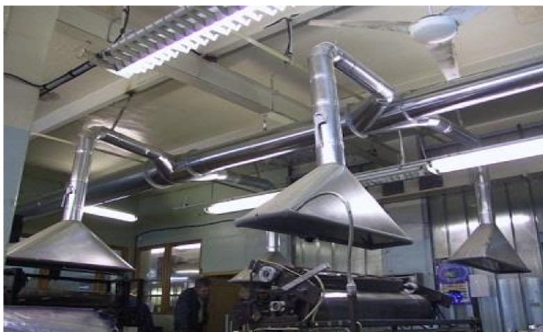
Рис. 1. Местная вытяжная вентиляция (зонты)
