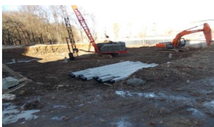
Фото 2. Забивка составных свай при строительстве жилого дома в г. Владимире.
