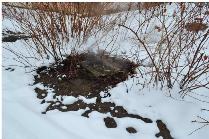
Рис. 3. Фотография неизолированного участка подземной прокладки тепловой сети
