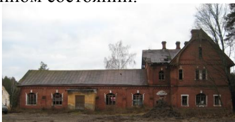
Рис. 5. Существующее состояние скотного двора и мельницы усадьбы Грузинских-Шорыгиных. Фото 2011 г. Из личного архива автора.
