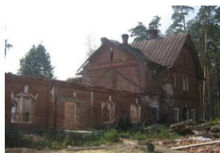
Рис.1. Западный фасад Скотного двора с мельницей
