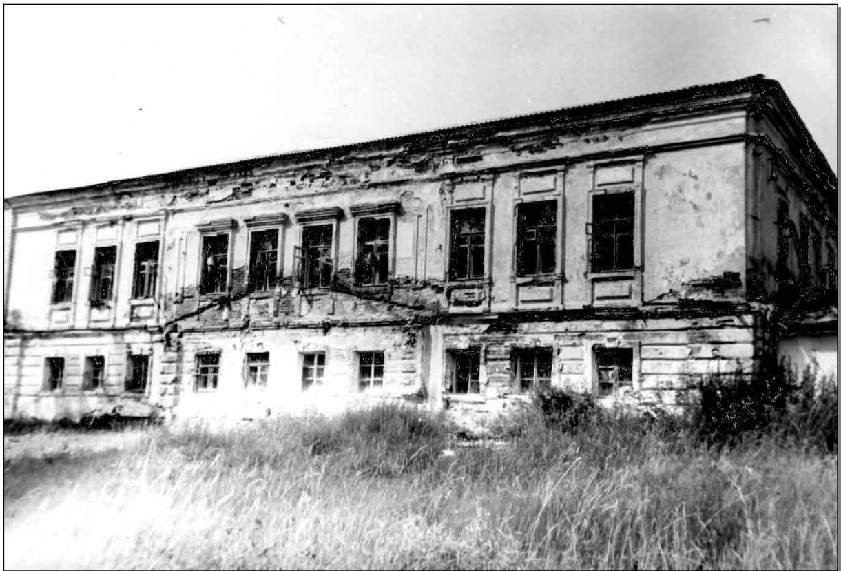
Рис.5. Усадьба «Омофорово» Дубровских. Господский дом
