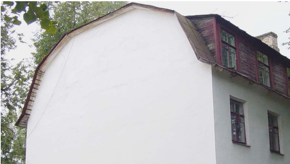
Рис. 2.7. Вид здания с мансардным покрытием (г. Ковров)
