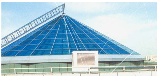
Рис. 1.3. Виды остекленных светопрозрачных покрытий общественных зданий: а – с арочными несущими конструкциями; б – купольный
