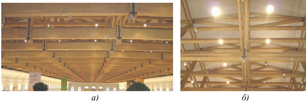
Рис. 3.2. Фрагменты вида несущих конструкций покрытия Манежа в Москве после восстановления: а – общий вид конструкций; б – фрагмент покрытия
