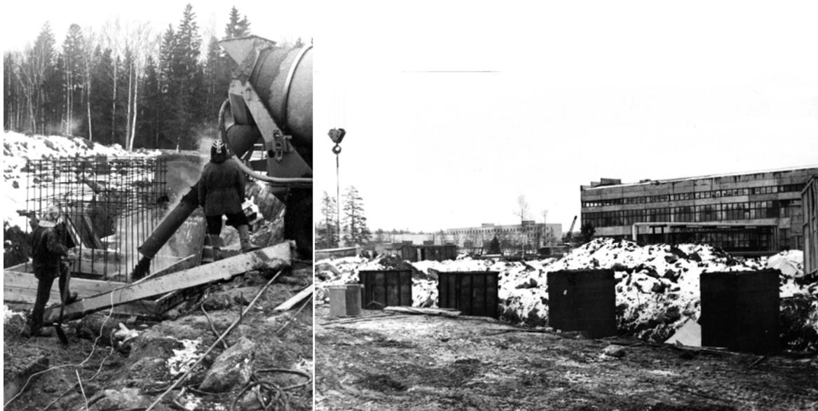
*Рис. 7.9. Укладка пароразогретой в АБС бетонной смеси в опалубку фундаментов по лотку и утепление колпаками из ДВП*
