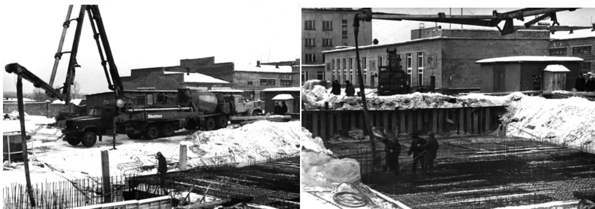
*Рис. 7.14. Бетонирование пароразогретыми смесями
