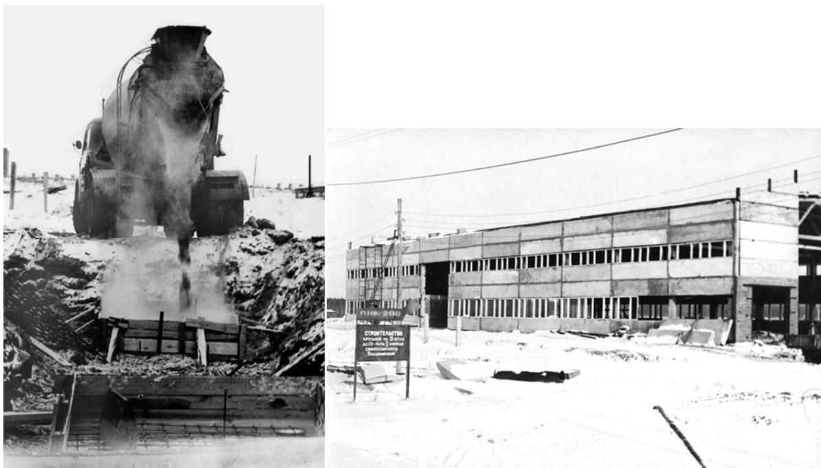
*Рис. 7.1. Первые монолитные конструкции, возведенные с применением пароразогретых в АБС бетонных смесей, - фундаменты здания котельной*
