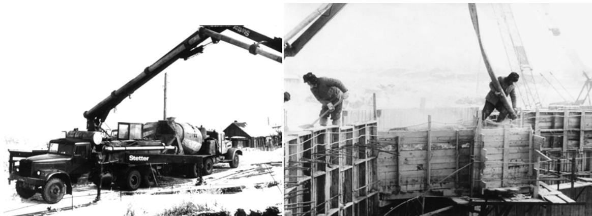
*Рис. 7.15. Бетонирование пароразогретой смесью густоармированной конструкции резервуара*
