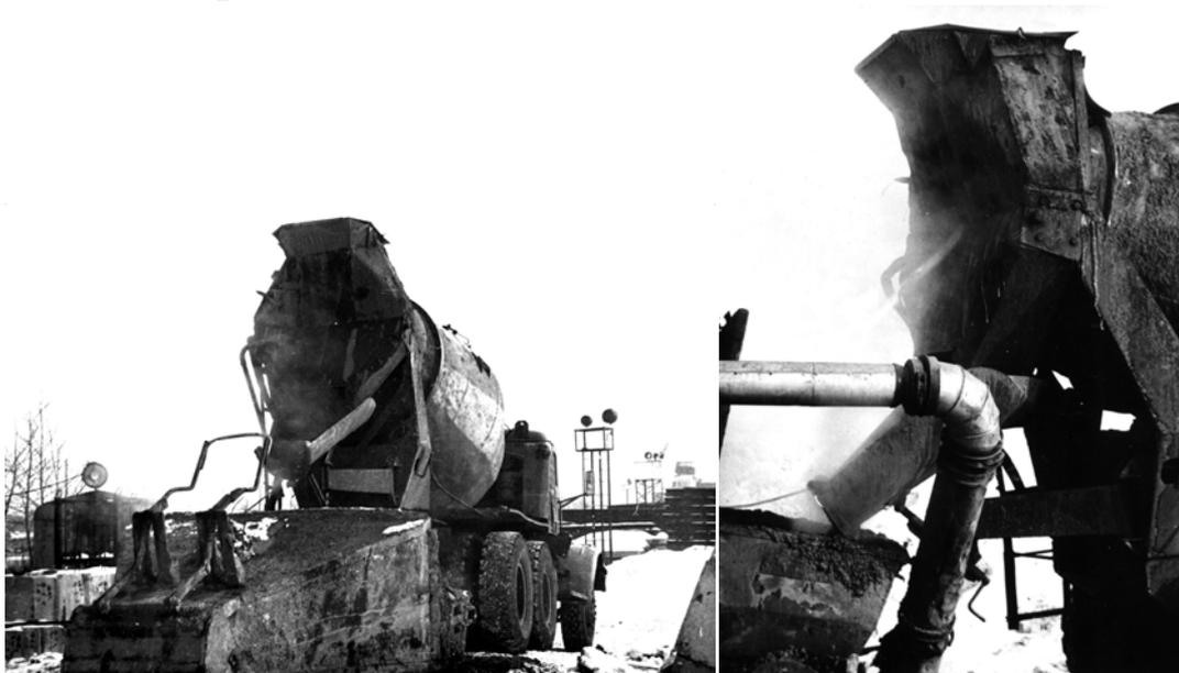
*Рис. 7.13. Перегрузка пароразогретой бетонной смеси из АБС в металлический бункер с подачей краном или в приемный бункер АБН*
