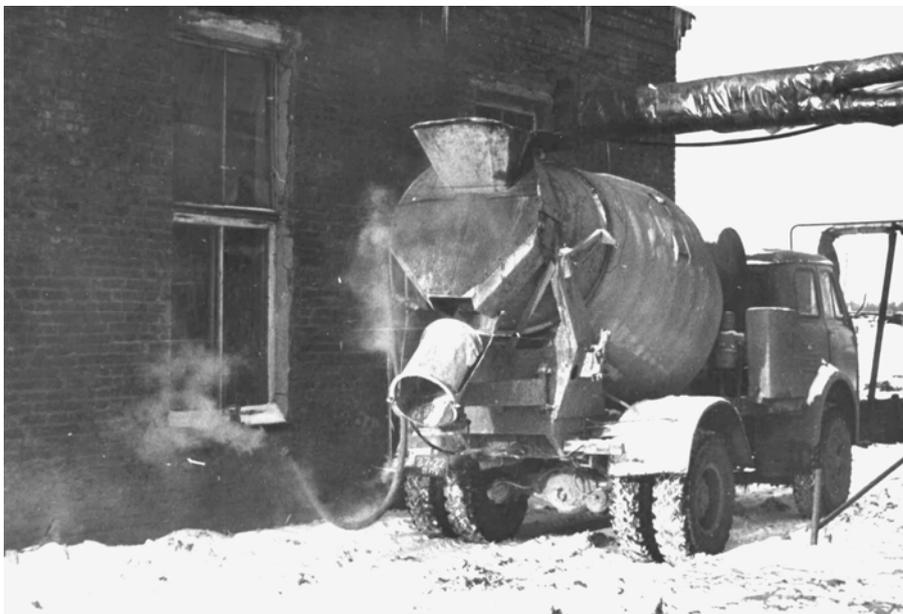
*Рис. 7.6. Оборудование поста пароразогрева бетонной смеси в АБС на строительной площадке*
