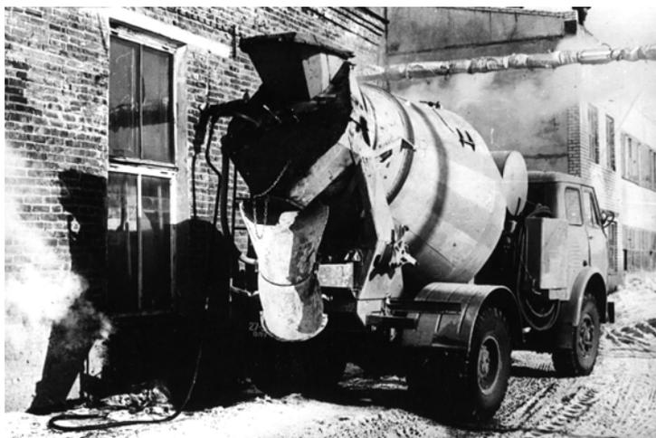
*Рис. 7.3. Разогрев компонентов бетонной смеси в АБС паром, поступающим из существующей на строительной площадке котельной*
