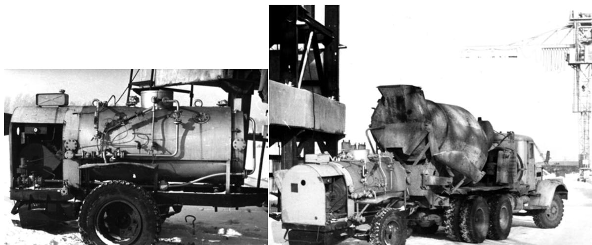
*Рис. 7.12. Разогрев компонентов бетонной смеси в АБС паром от парообразователя Д-563*
