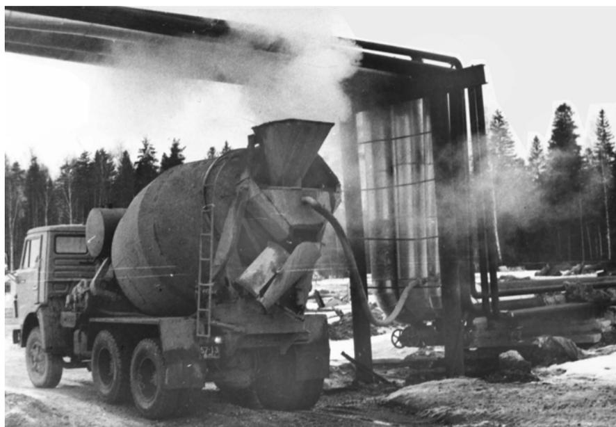
*Рис. 7.8. Разогрев паром от паропровода на строительной площадке*
