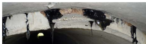
Рис. 7. Осадка полуколец трубы у шельги
