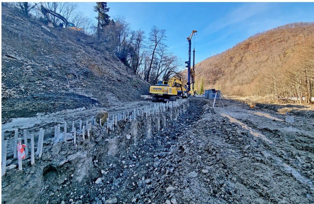
Рис. 3.3. Работы по укреплению склонов от оползней
