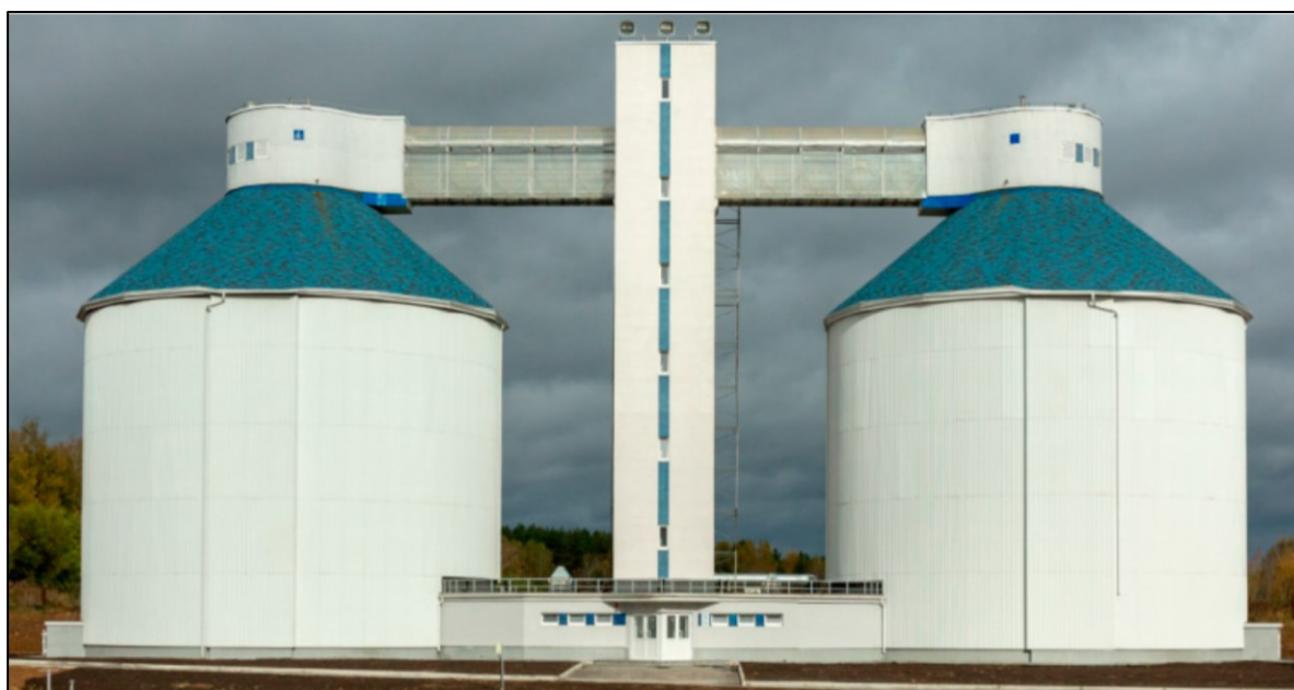
Рис. 82. Метантенки на станции очистки сточных вод в Екатеринбурге [70]
