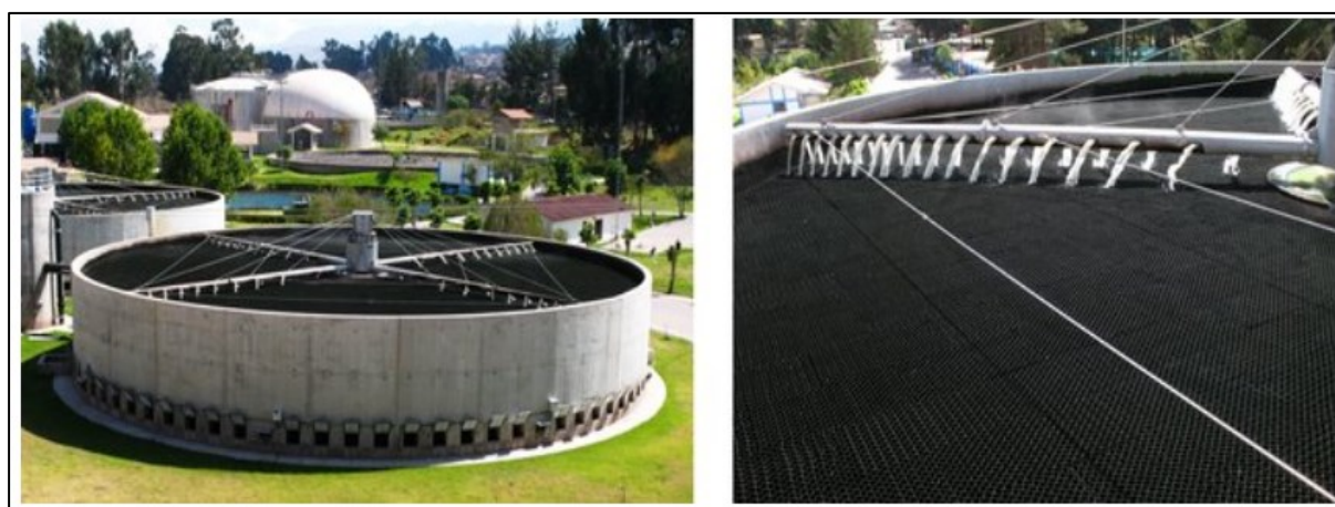
Рис. 38. Пластиковый фильтрующий элемент с поворотным гидравлическим распределителем (слева) и система распределения крупным планом (справа) [39]
