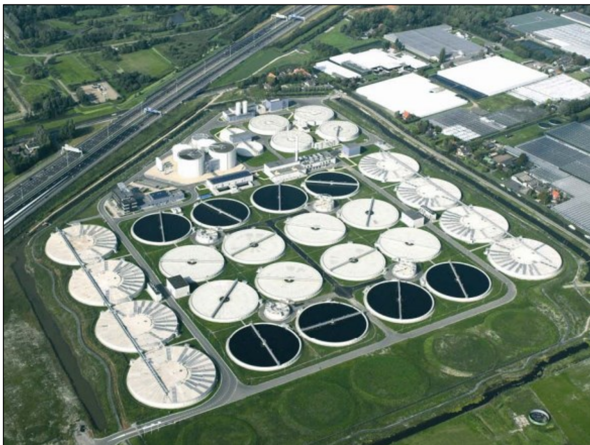
Рис. 35. Станция очистки сточных вод [36]
