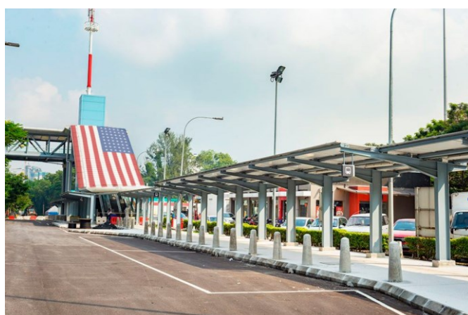
Рис. 1. Защитные бетонные столбы в США
