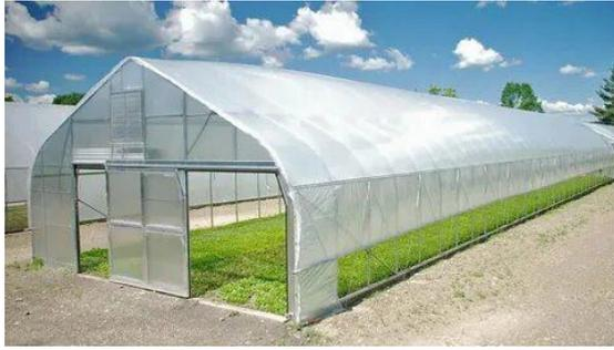
Рисунок 3 - Теплица из полимерной пленки
