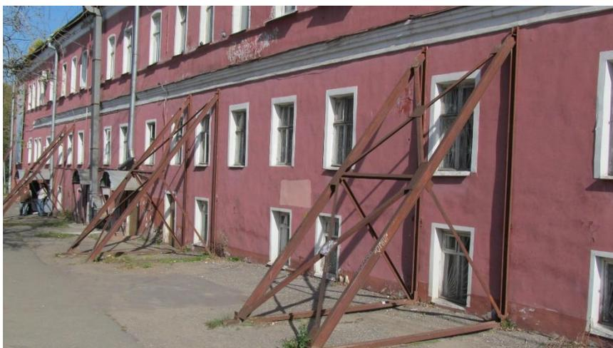
Рисунок 13 - Фрагмент фасада с использованием контрфорсов [3]
