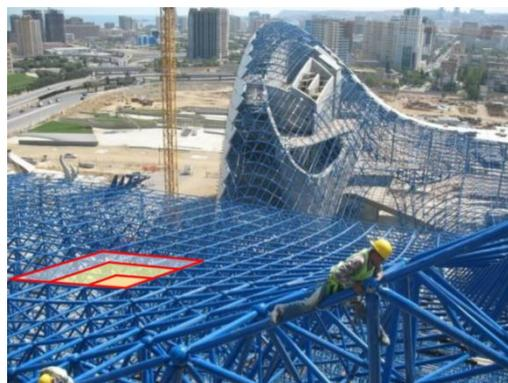
Рисунок 15 - Перекрёстно-стержневые конструкции
