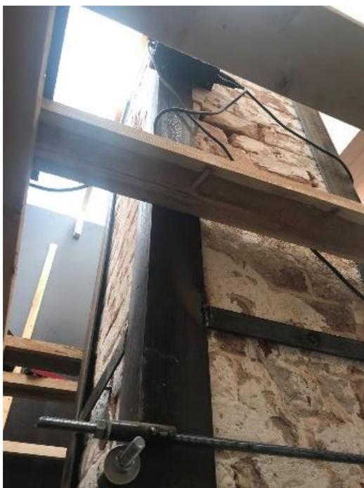
Рисунок 5 - Работы по стягиванию металлических уголков обоймы [проект]
