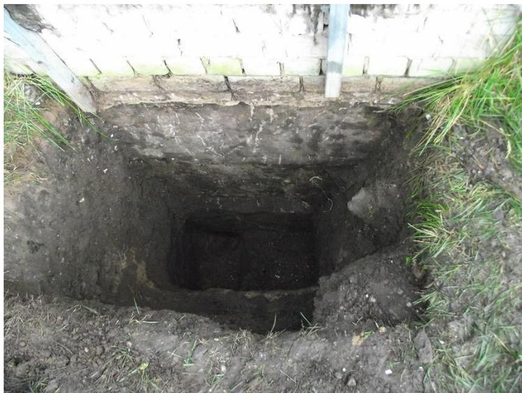
Рисунок 2 – Шурф №1 у наружной стены здания
