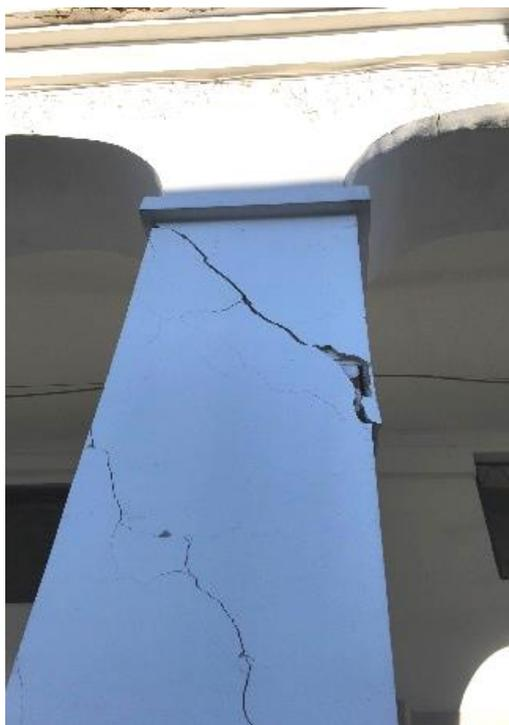
Рисунок 4 - Косонаправленные трещины в кладке столба [проект]
