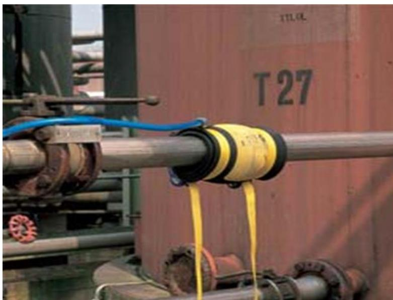
Рисунок 2 – Устранение утечки на газопроводе с применением пневмобандажа
