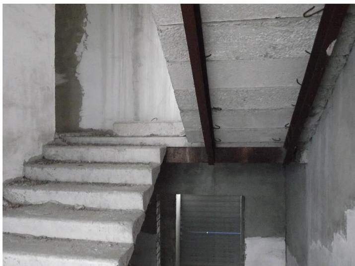
Рисунок 5 – Коррозия стальных косоуров и балок
