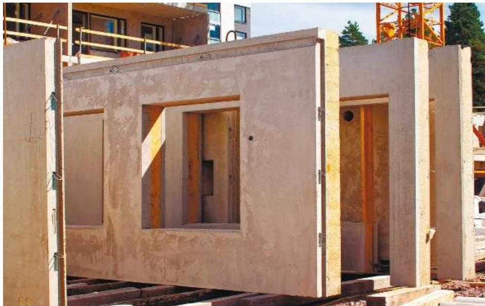
Рисунок 3 - Сборные стеновые панели
