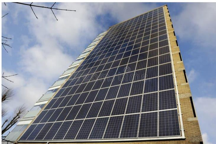
Рисунок 6 – Вид фасада здания с солнечными батареями
