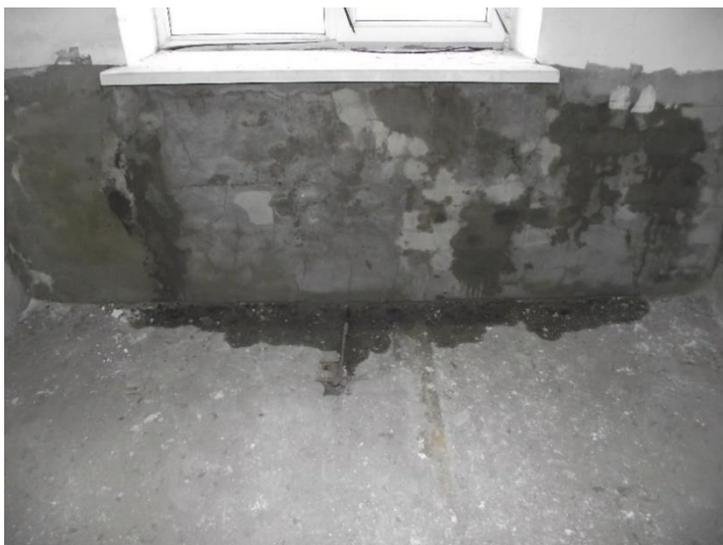
Рисунок 3 – Протечки в стене под оконным проемом
