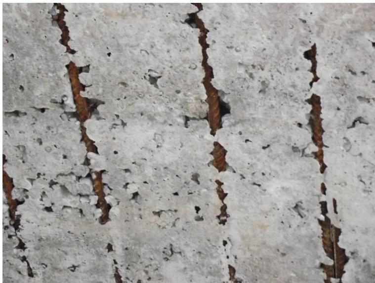
Рисунок 4 – Разрушение защитного слоя бетона на участке монолитного покрытия над вторым этаж
