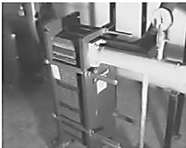
Рис. 2.8. Пластинчатый водоподогреватель в сборе
