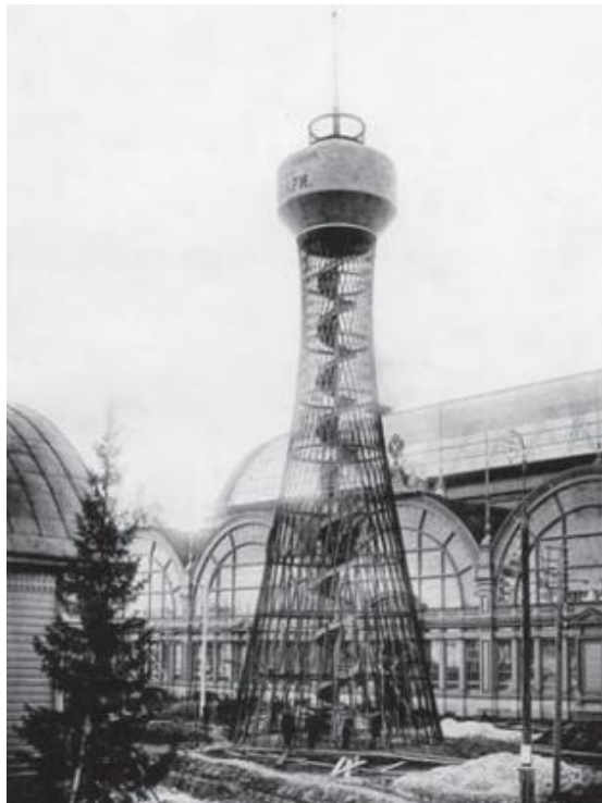
Рис.18. Водонапорная башня на Всероссийской промышленной и художественной выставке 1896 года в Нижнем Новгороде
