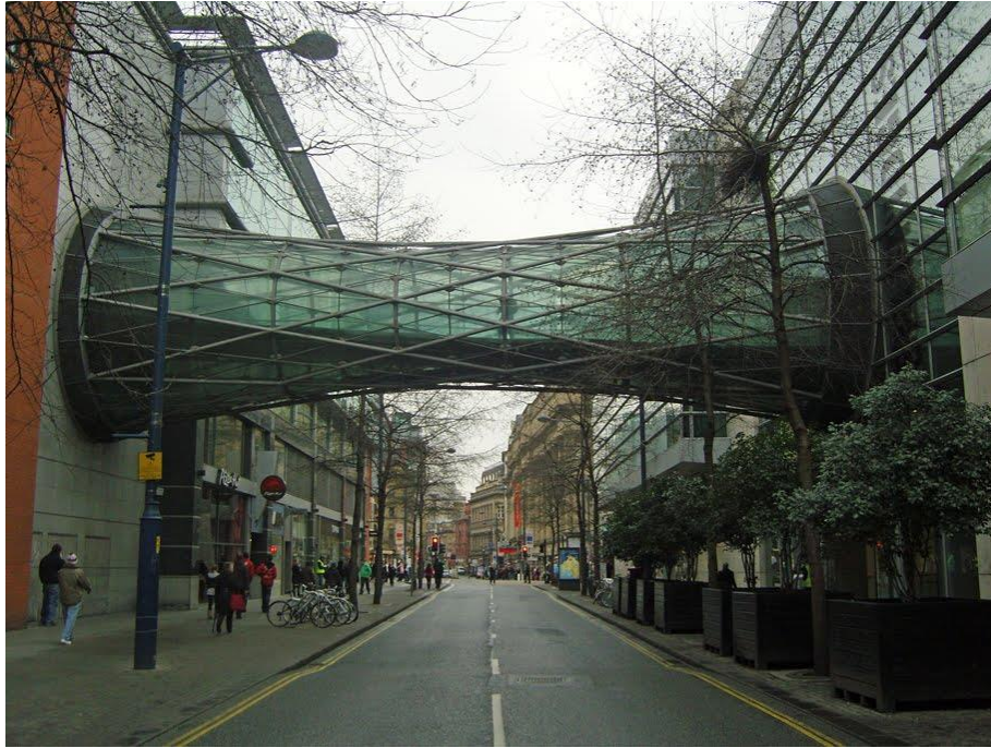
Рис.33. Гиперболоидный мост в Манчестере - Corporation street bridge
