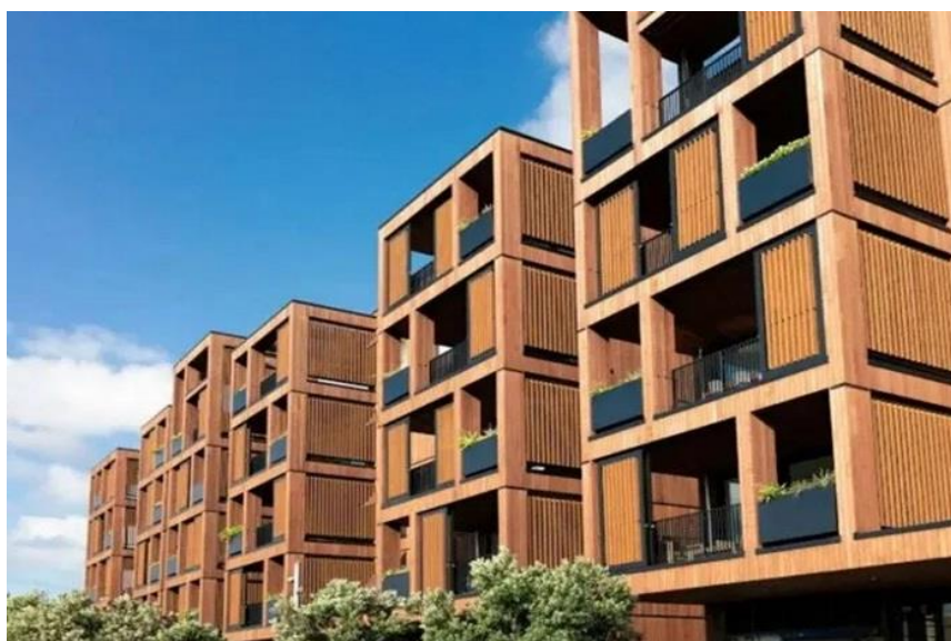
Рис. 2.9. Четырехэтажный жилой дом в г. Сокол
