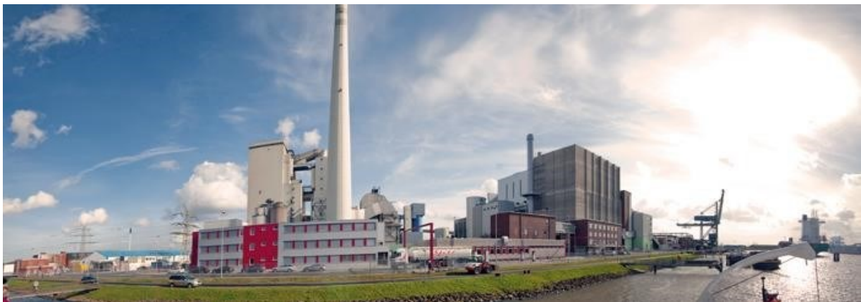
Abb. 13. Müllverbrennungsanlagen in Bremen
