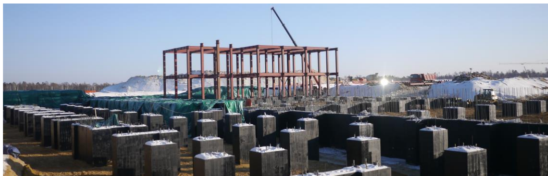
Рис. 2.14. Строительство стартовой площадки
