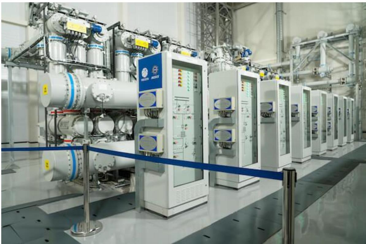
Рис. 4.3. Цифровые терминалы РЗА НПП «ЭКРА» КРУЭ 110 кВ
