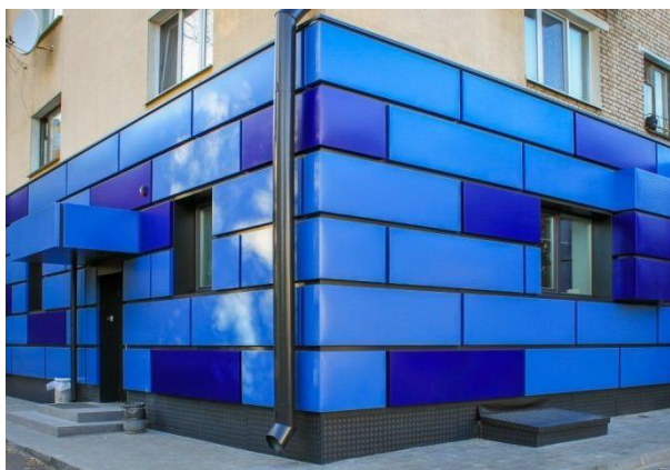
Рис. 1.13. Композитные облицовочные панели для зданий и сооружений
