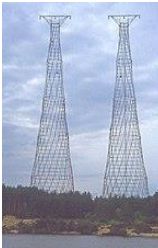
Рисунок 2 – Гиперболоидные опоры ЛЭП (фото 1994 г., тогда опор было еще две)
