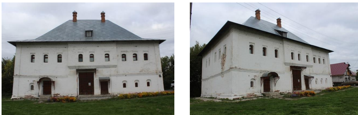
Рисунок 1 – Общий вид южного и западного фасадов здания
