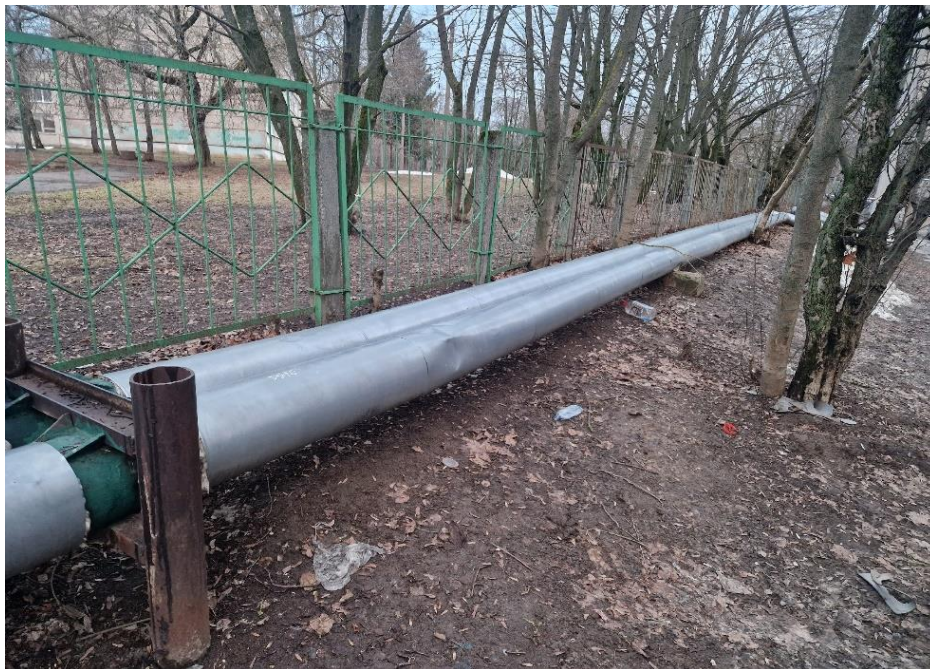
Рисунок 1 – Исследуемый участок трубопровода (тепловой сети)
