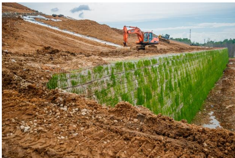
Рисунок 16 - Ход работ на мусорном полигоне в Часцах
