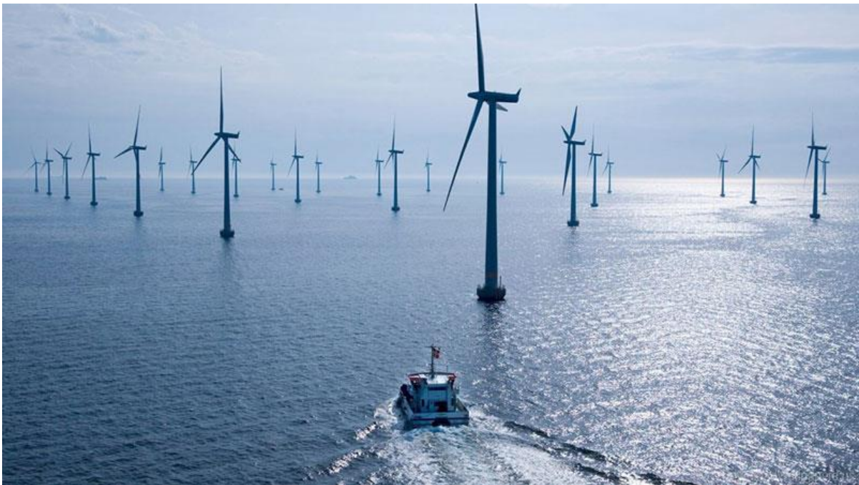
Рисунок 6 - Ветроэлектростанция в открытом море
