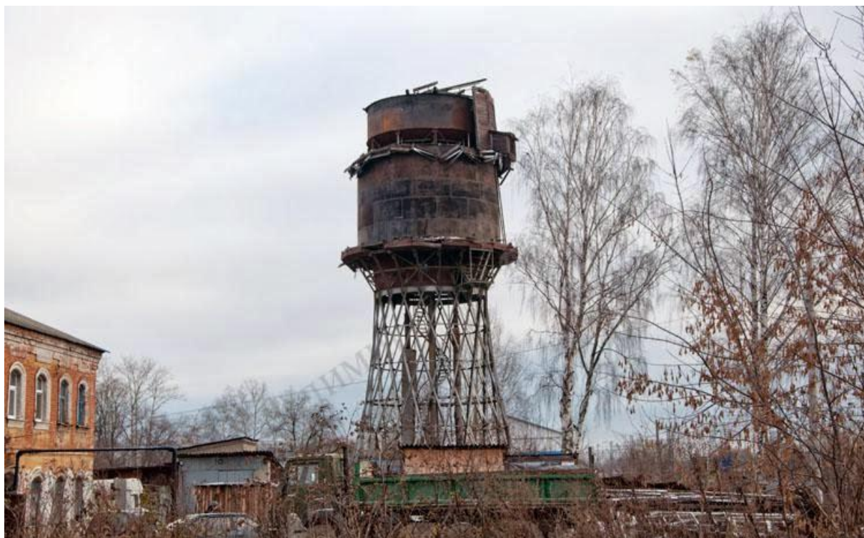
Рисунок 1 – Гиперболоидная башня в г. Петушки (это вид до реставрации)
