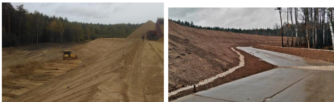
Рисунок 13 - Завершающий этап рекультивации свалки в Оргтруде
