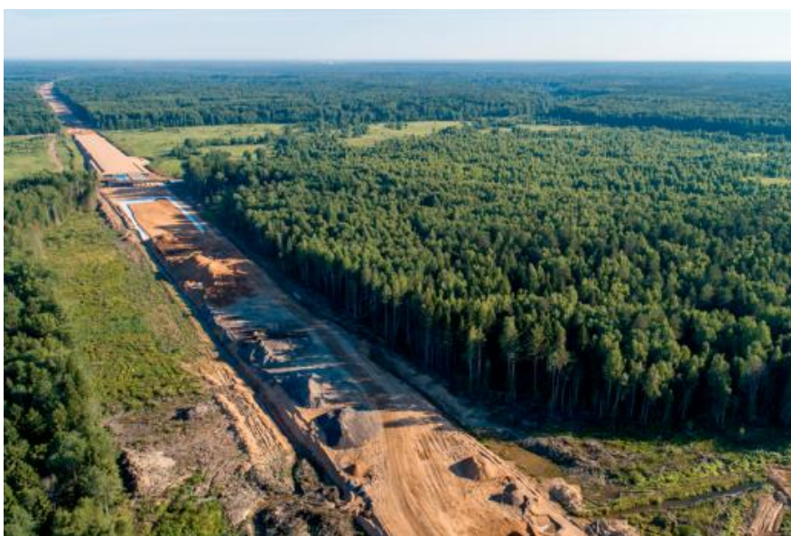
Рисунок 10 - Восстановление нарушенных земель
