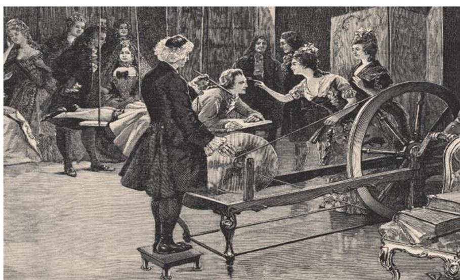
*Опыты аббата Нолле с электрической индукционной машиной
