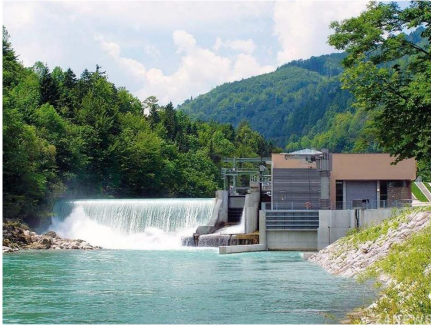
Рис. 5.4. Малая ГЭС Forshult, Швеция
