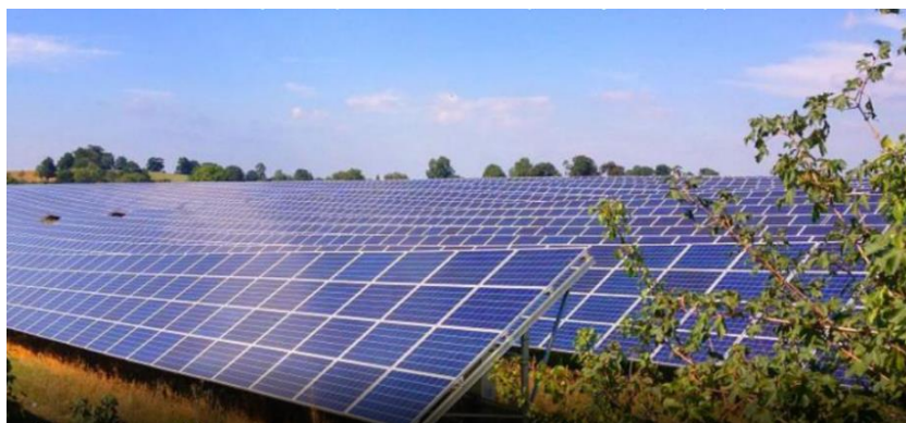
Рис. 5.6. Солнечные ФЭУ с плоскими кремниевыми модулями
