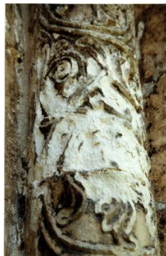
Рис. 4. Фрагмент разрушений белокаменной резьбы на колонке портала Георгиевского собора. Современное состояние
