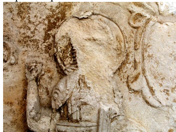
Рис. 5. Разрушение белокаменной резьбы на южном фасаде Георгиевского собора. Современное состояние
