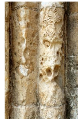
Рис. 4. Фрагмент разрушений белокаменной резьбы на колонке портала Георгиевского собора. Современное состояние
