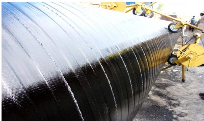
*Рис. 6.8. Нанесение липких полимерных лент*
