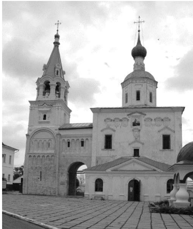
Вид собора после реставрации 1950 – 1960-х гг. Фото А. И. Скворцова. 2008
