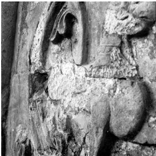
Владимир Дмитриевский собор. 1194 – 1197 Процесс восстановления резьбы на барабане методом докомпоновки. 1970-е гг.
