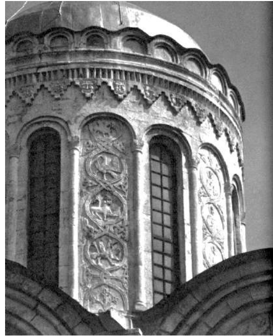
Владимир Дмитриевский собор. 1194 – 1197 Процесс восстановления резьбы на барабане методом докомпоновки. 1970-е гг.
