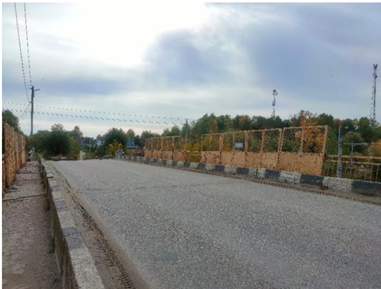
Путепровод на пересечении ул. Карла Либкнехта – ул. Коруновой
