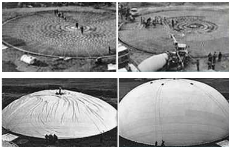
Рисунок 1 – Процесс создания дома по технологии бинишелл
