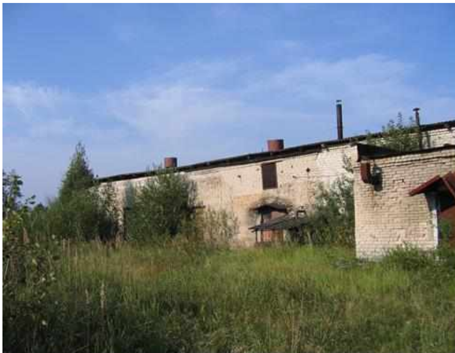
Рисунок 1 - Общий вид здания со стороны главного фасада
