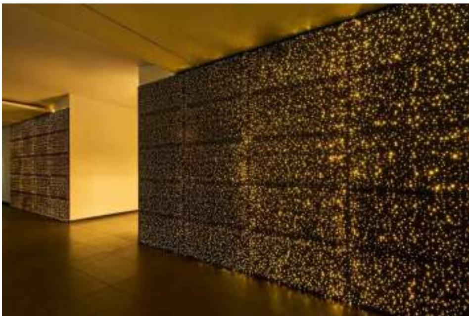
Рисунок 4 - Применение светопрозрачного бетона
