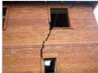
Рисунок 2 – Проявление деформации сдвига в здании
