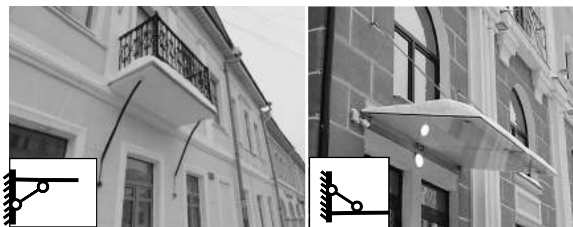
Рисунок 7 – Опоры балконов и навесов (фото с улиц г. Владимира)
