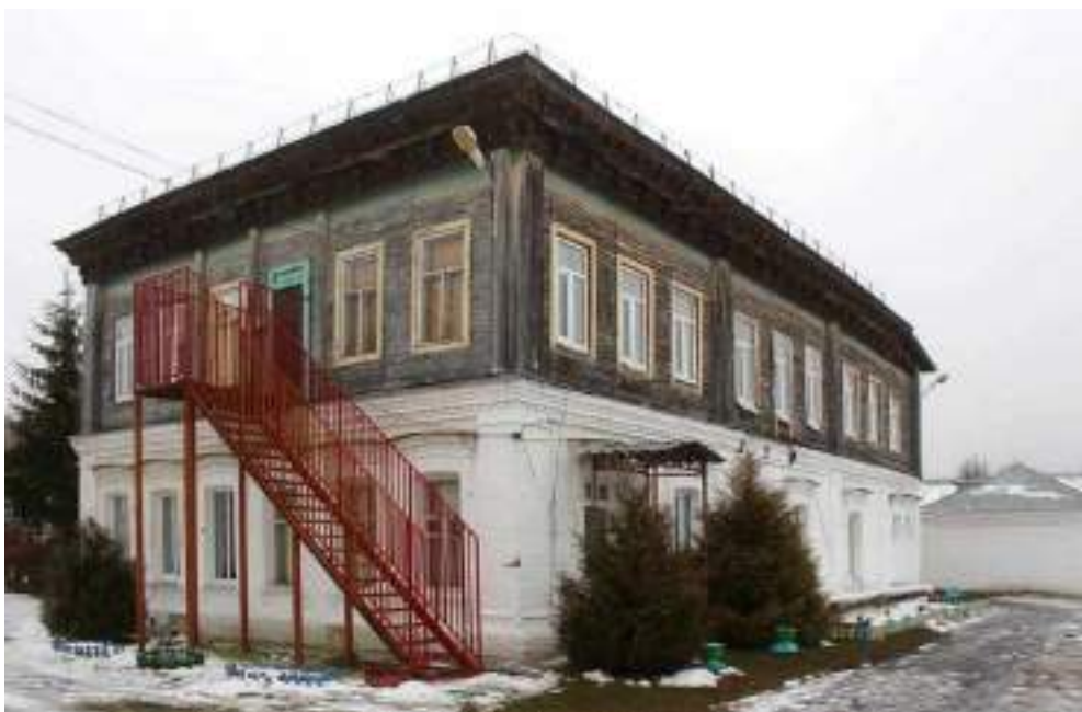
Рисунок 1 - «Усадьба Носовых. Дом с лавкой» в с. Фоминки. Общий вид западного и главного фасада дома усадьбы
