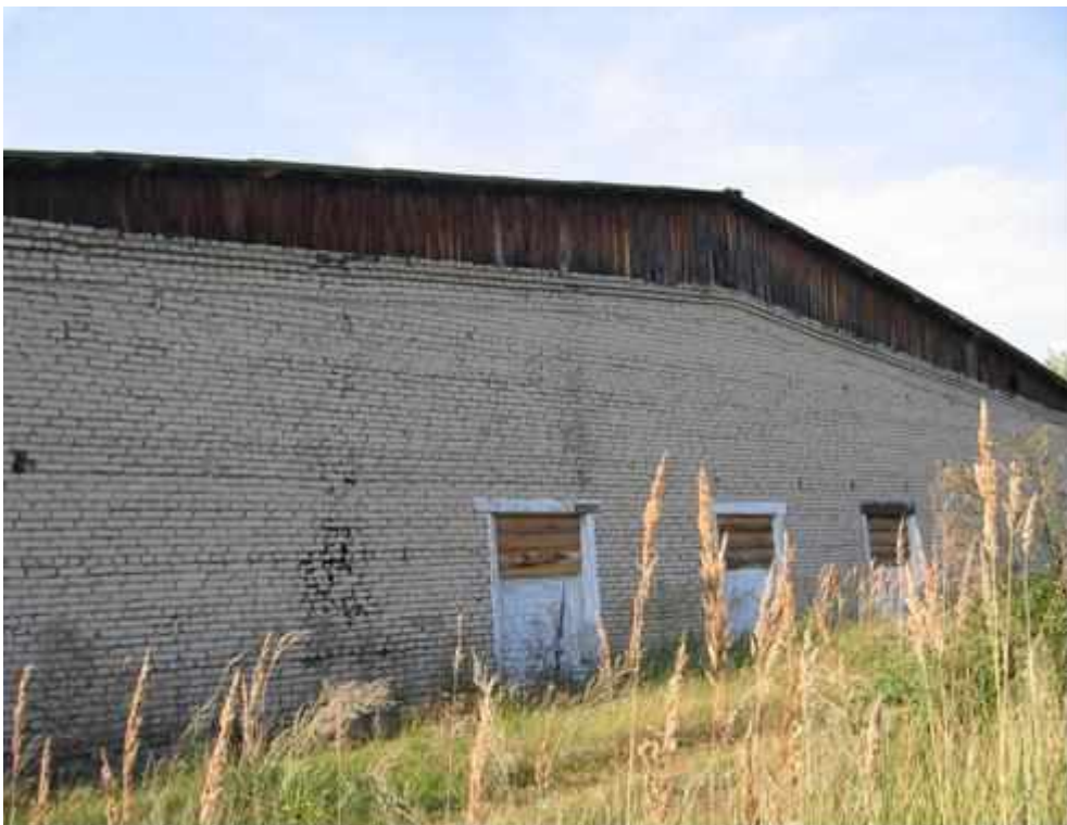
Рисунок 4 - Общий вид торцевого фасада
