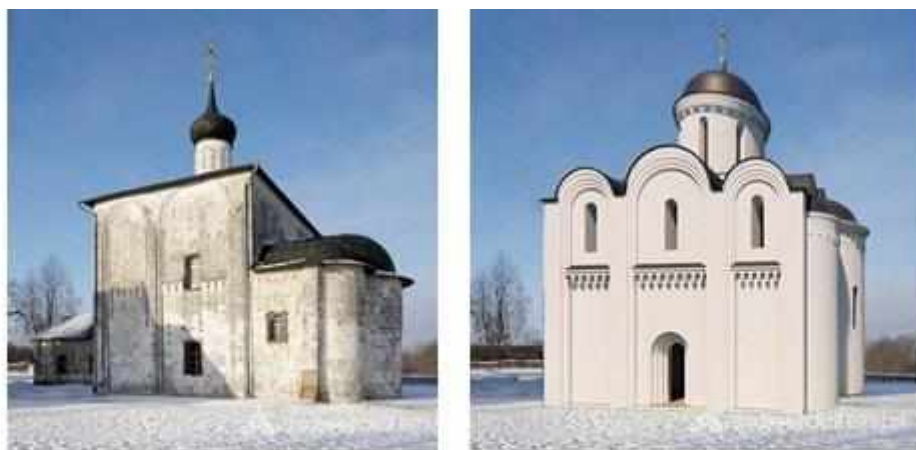
Рисунок 9-10 – Храм Бориса и Глеба в Кидекше. Сравнение современного вида фасада и предположительной реконструкции фасада до XVII века (реконструкция автора)
