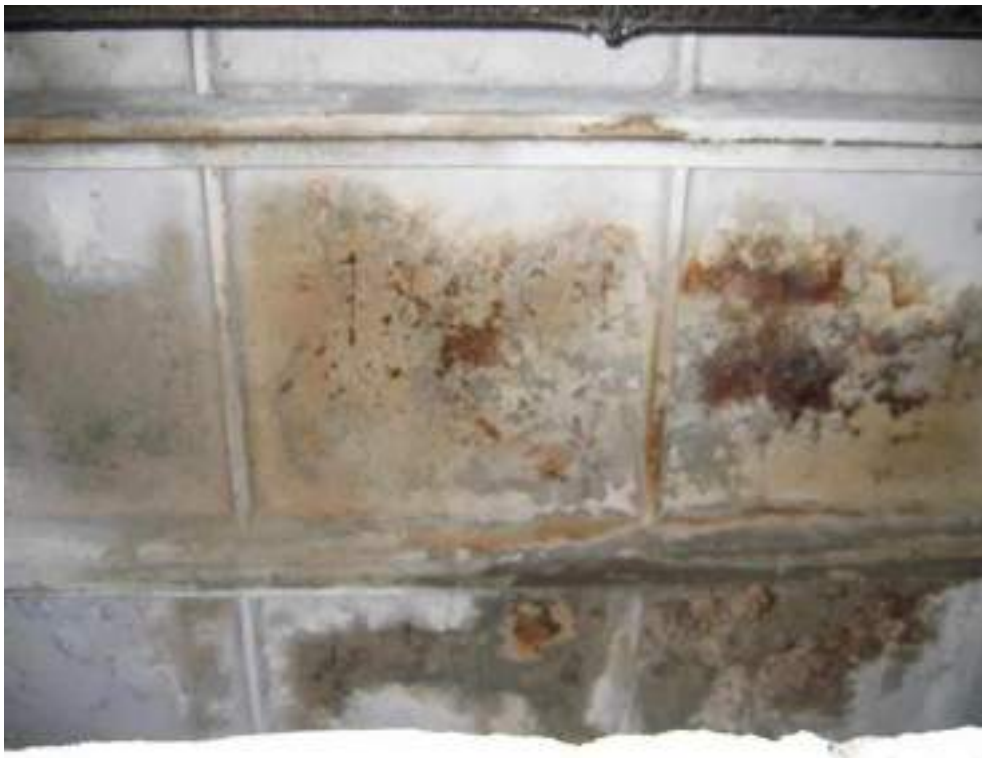
Рисунок 8 – Протечки кровли
