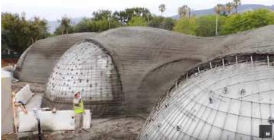
Рисунок 2 – Процесс наложения бетона
