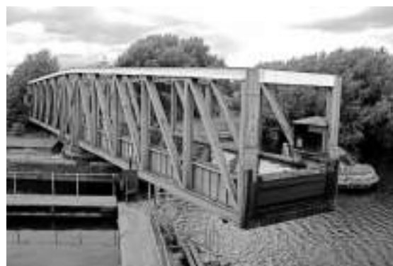
Рисунок 6 - Мост на подвижной опоре
