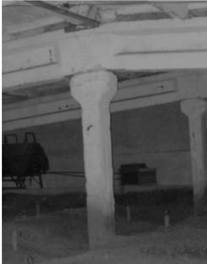
Рисунок 15 – Общий вид железобетонных колонн
