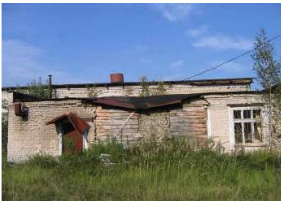
Рисунок 2 - Общий вид фасада со стороны лаборатории
