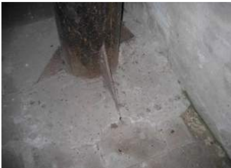
Рисунок 16 – База стальной колонны
