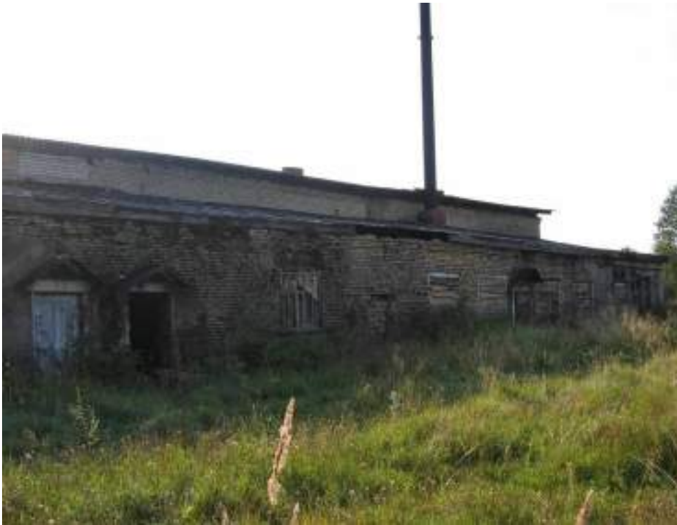
Рисунок 3 - Общий вид фасада со стороны котельной
