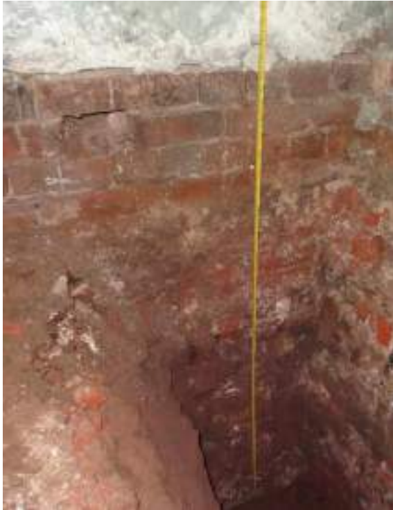
Рисунок 3 - Выполненный шурф в осях (Б–В)/ (1–2) в месте сопряжения внешней и внутренней стен
