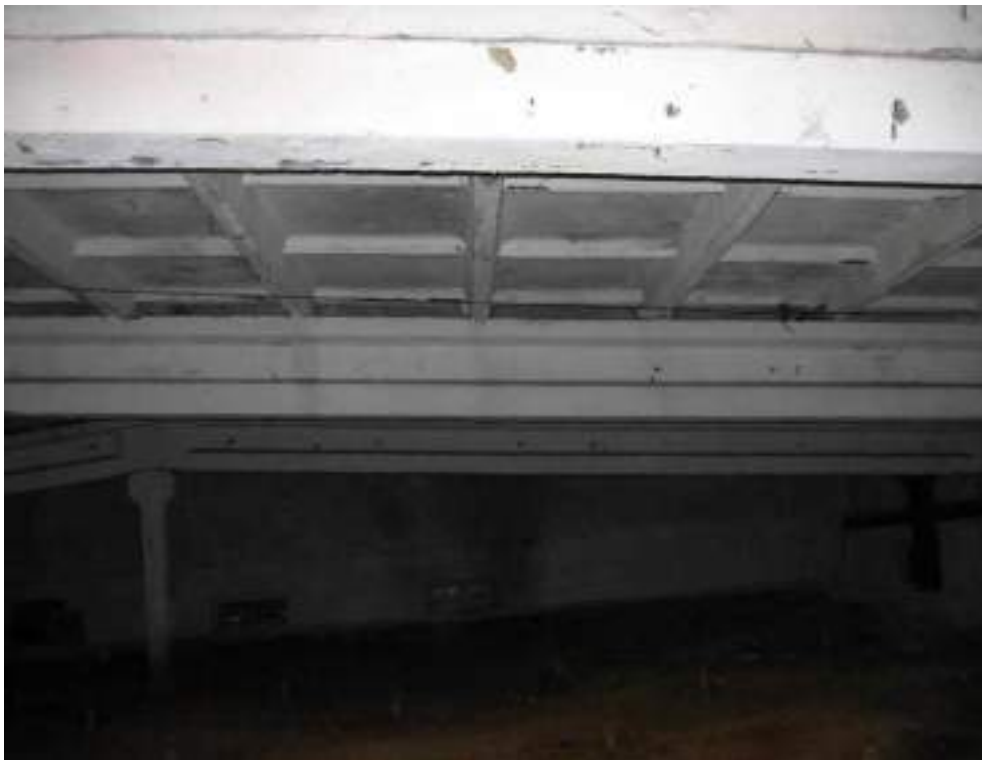
Рисунок 5 – Общий вид балок покрытия
