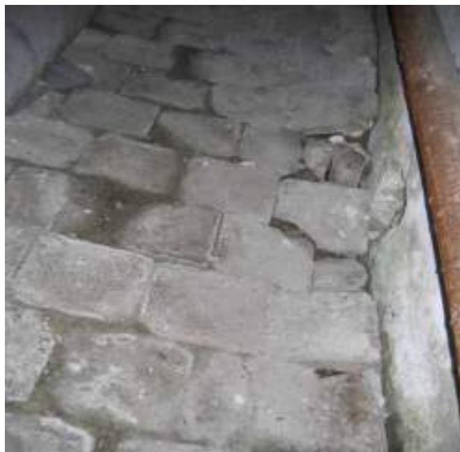
Рисунок 19 – Просадка пола
