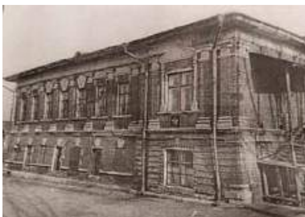
Рисунок 1 - Дом купца Сыромятникова 1840 г. (архивное фото). Вид на северный фасад
