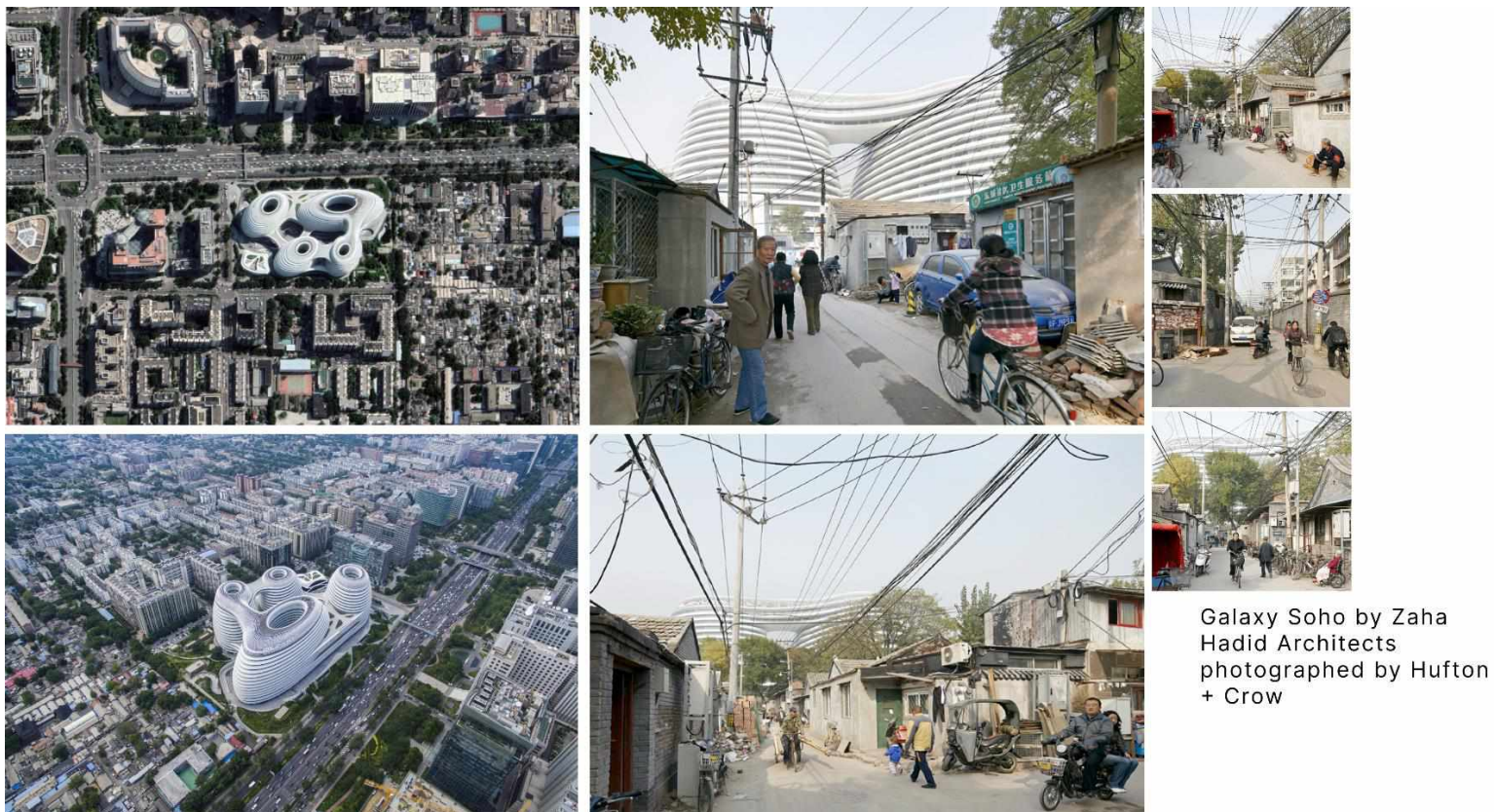
Рис.142 Центр Galaxy Soho, г. Пекин, в архитектурной среде импульсно меняющейся застройки
