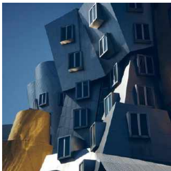
Рис.89 MIT Stata Center Building (Boston, Massachusetts)
