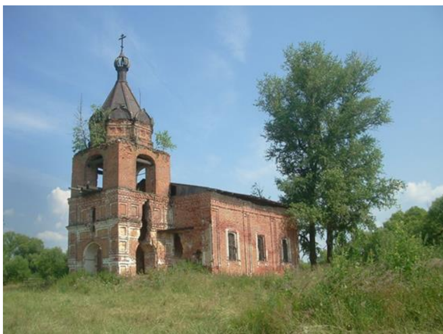
Рисунок 2 - «Троицкая церковь», 1881 г, Владимирская обл., Петушинский р-он, д. Головино. Фрагмент южного и западного фасада церкви. Фото выполнено 5 июля 2013 г. Автор фотографии: Громакова Е.
