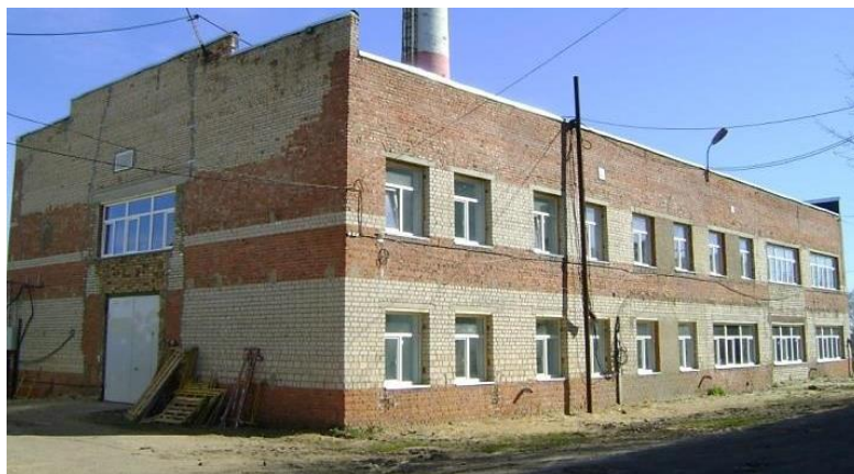
Рисунок 1 – Исходное состояние фасадов здания
