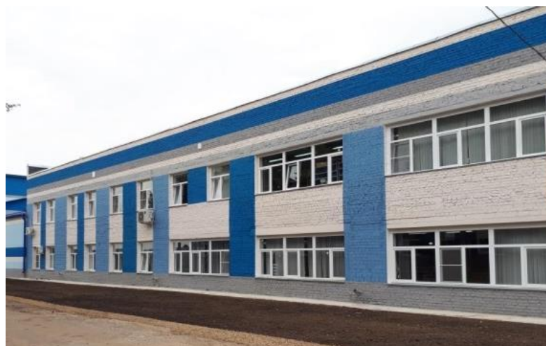
Рисунок 4 - Итоговое состояние фасадов здания
